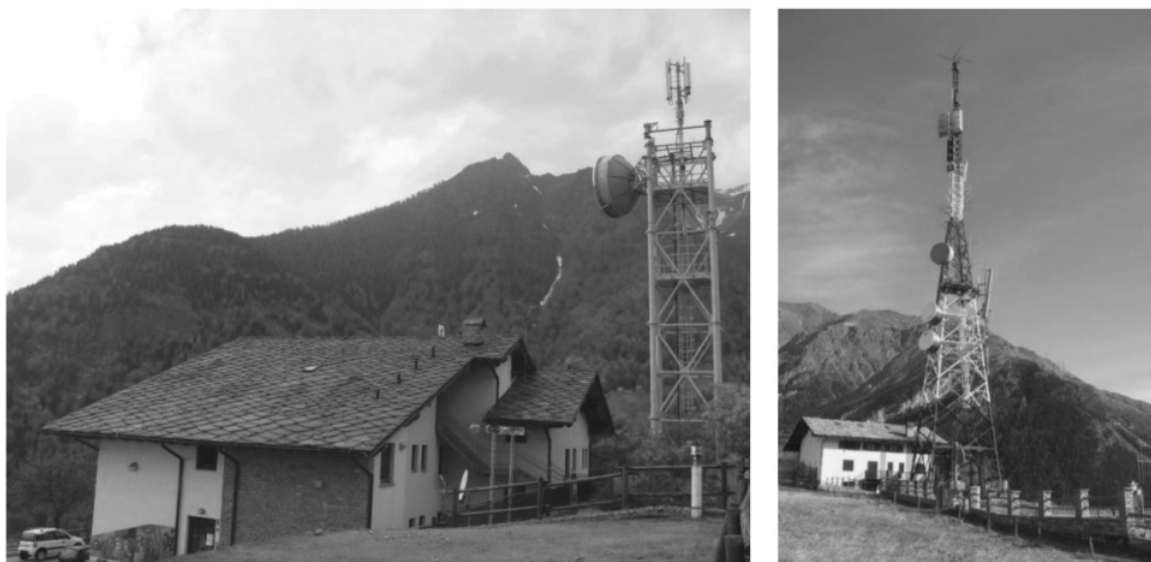
Figura 4: Foto di due strutture di ricezione turistica la cui attrattività è pregiudicata dalla presenza di imponenti impianti di radio telecomunicazioni.
