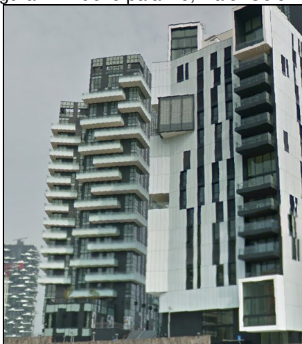
Figura 4 - Nuovo palazzo, via J. Colombo
