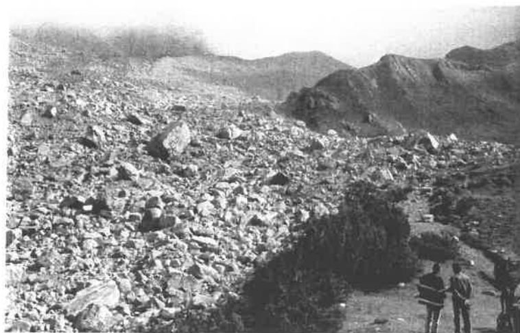
4. Il deposito di frana ha interrotto la carrozzabile che sale al rifugio V Alpini.
